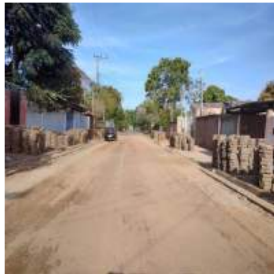
RETIRADA DE BLOQUETES, LIMPEZA E EMPIHAMENTO
