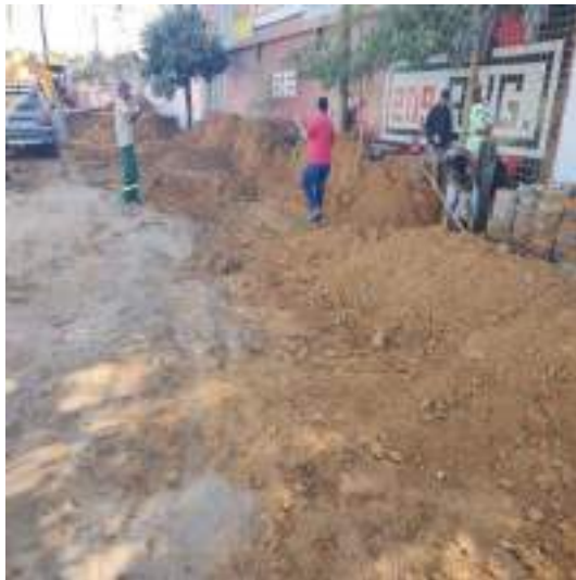
ABERTURA DE VALA, ASSENTAMENTO DE TUBOS E REATERRO
