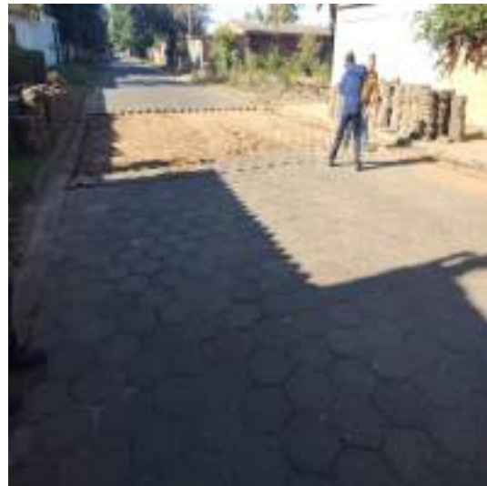
RETIRADA DE BLOQUETES, LIMPEZA E EMPILHAMENTO
