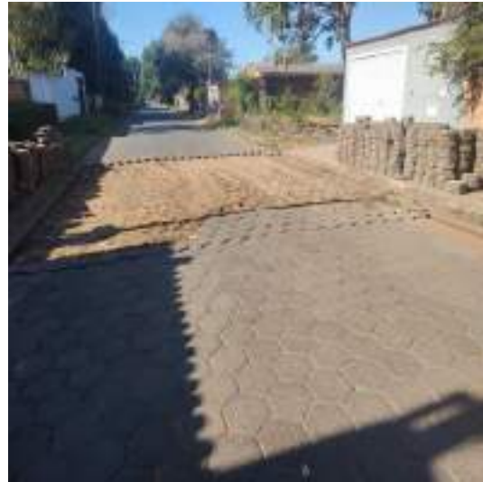
RETIRADA DE BLOQUETES, LIMPEZA E EMPIHAMENTO
