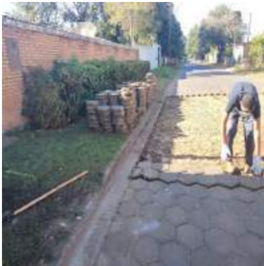
RETIRADA DE BLOQUETES, LIMPEZA E EMPILHAMENTO
