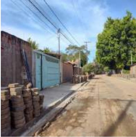
RETIRADA DE BLOQUETES, LIMPEZA E EMPIHAMENTO
