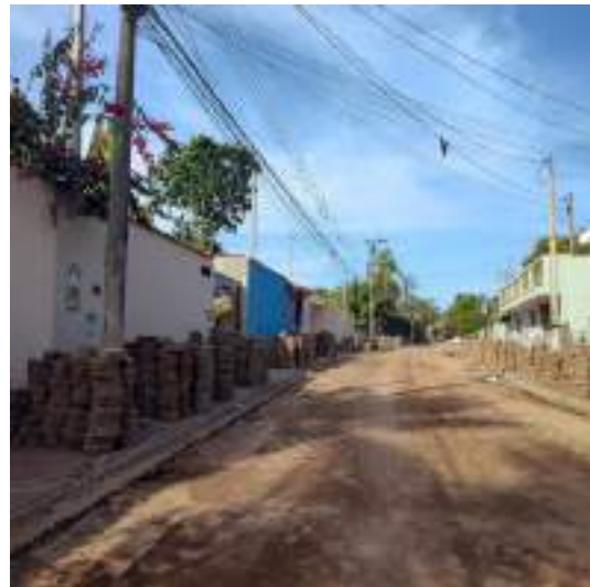
RETIRADA DE BLOQUETES, LIMPEZA E EMPIHAMENTO
