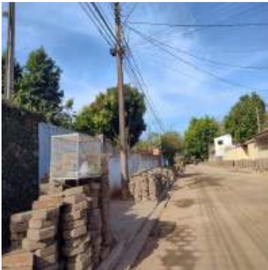
RETIRADA DE BLOQUETES, LIMPEZA E EMPIHAMENTO
