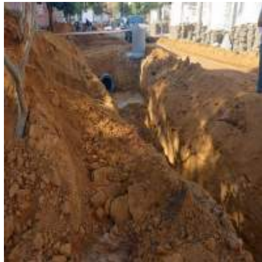
ABERTURA DE VALA, ASSENTAMENTO DE TUBOS E REATERRO
