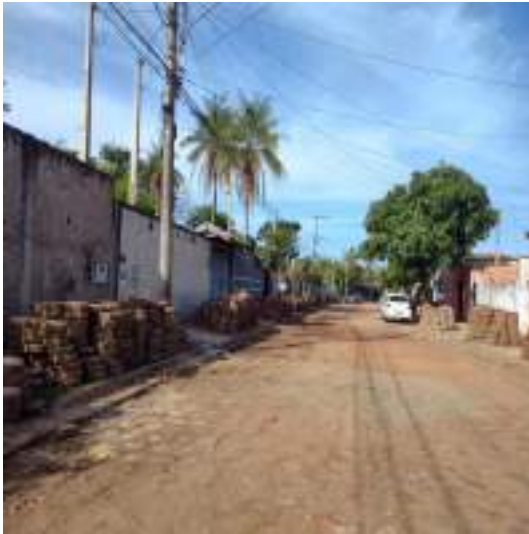
RETIRADA DE BLOQUETES, LIMPEZA E EMPIHAMENTO
