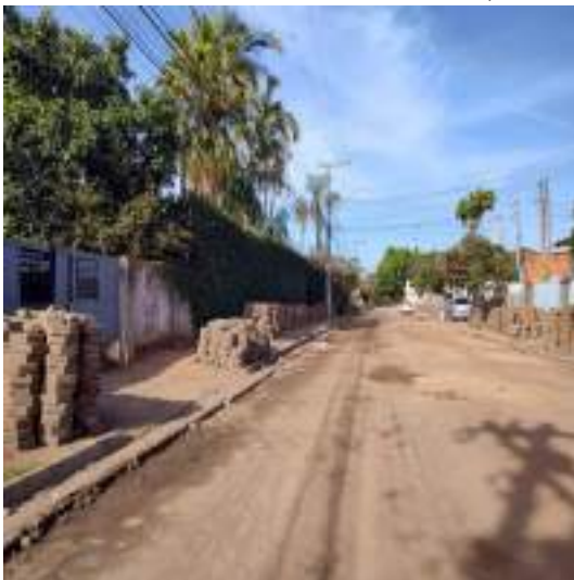
RETIRADA DE BLOQUETES, LIMPEZA E EMPIHAMENTO
