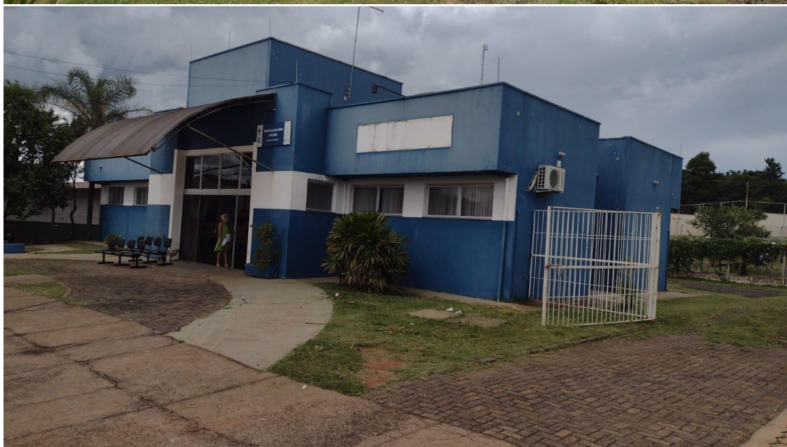
UBS Darcy Rippa (Jardim Porto Novo) – Serviço realizado dia 03/01/2024.
